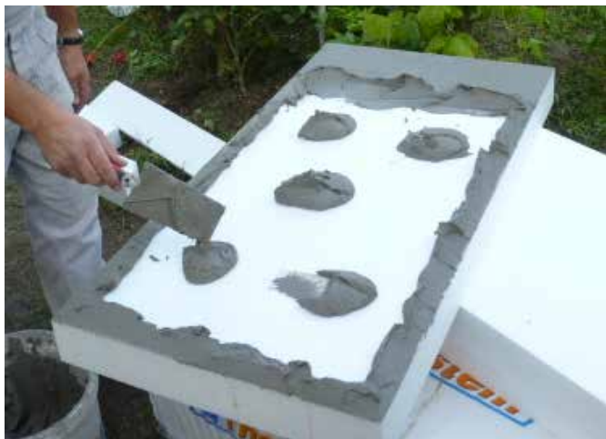
Rendszerragasztó kézi felhordása pont-perem módszerrel
