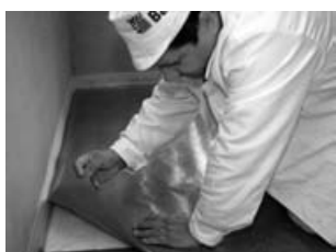
3.18 Az elválasztó fólia ráhelyezése a peremszigetelő sáv fóliájára
