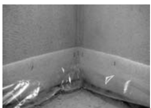
2.19 A peremszigetelő sáv helyes elhelyezése a sarkoknál
