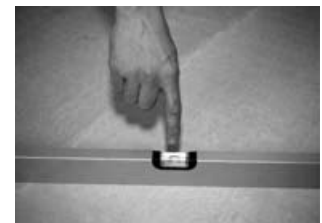
2.38 Az esztrich egyenetlenségének mérése vízmértékkel
