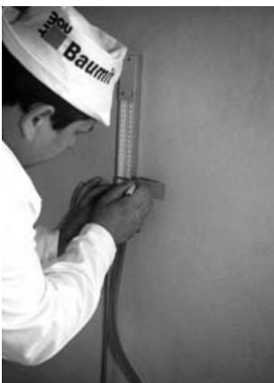
2.28 Az esztrichréteg tervezett magasságának kimérése
