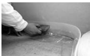
3.16 A padlószigetelő lemezek lefektetése
