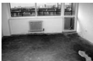
3.14 Előkészített alap
