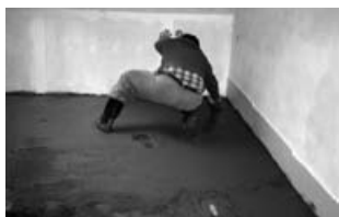
2.33 Az esztrichfelület simítása simítóval
