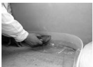
2.18 A peremszigetelő sáv elhelyezése
