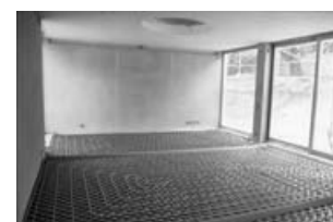
3.20 A padlófűtés csővezetékei pogácsás lemezbe rögzítve
