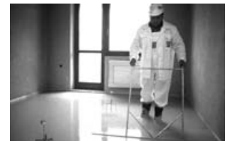
3.28 A friss önterülő esztrich réteg kezelése keretes szerszámmal
