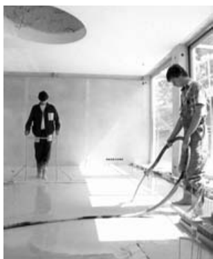
3.25 Anyag terítése a továbbító tömlő segítségével
