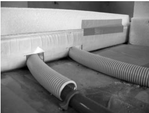
3.13 Vezetéknyomvonalak tágulási hézag esetén
