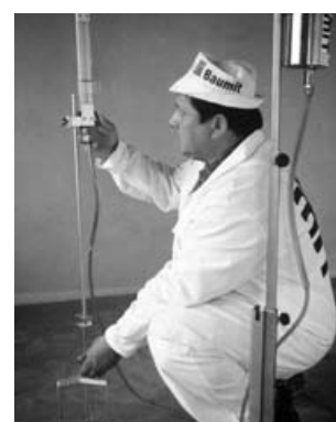
3.21 A önterülő esztrich réteg tervezett magasságának ki-mérése
