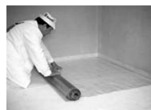
2.25 A Baumit Esztrich Fólia lefektetése
