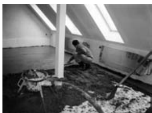
2.31 Cementesztrich beöntése az előkészített vezetősímentén
