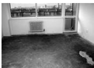
2.17 Előkészített fogadó szerkezet
