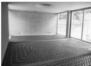
2.27 Speciális elválasztó fóliára rögzített padlófűtésrendszer
