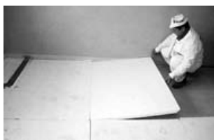
3.17 Szigetelő lemezek fektetése
