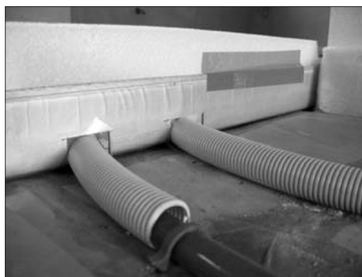
2.13 Csőnyomvonalak táglási hézag esetében
