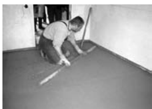
2.32 Cementesztrich lehúzása léccel
