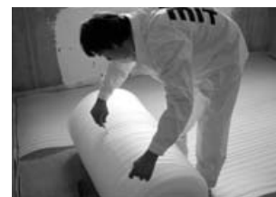
2.26 A lépéshang szigetelő réteg kialakítása
