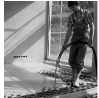
3.27 Az esztrich öntése – padlófűtés csöveinek beágyazása
